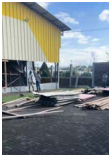
Reforma de abrigo.
