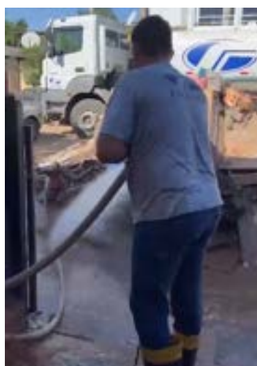
Disponibilização de equipamentos e funcionários para limpeza de entulhos.
